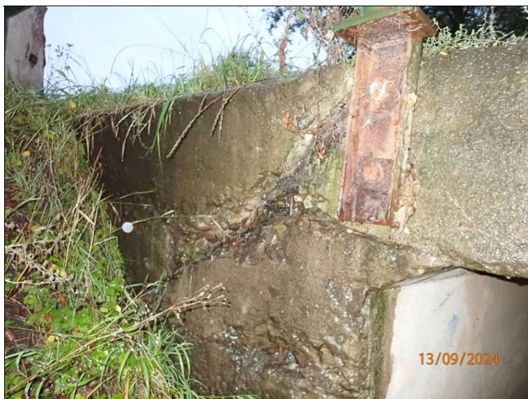
P bok opěry O1, detail od stojky a příčle odděleného + vysunutého P křídla, trhlina v rámovém rohu NK.
