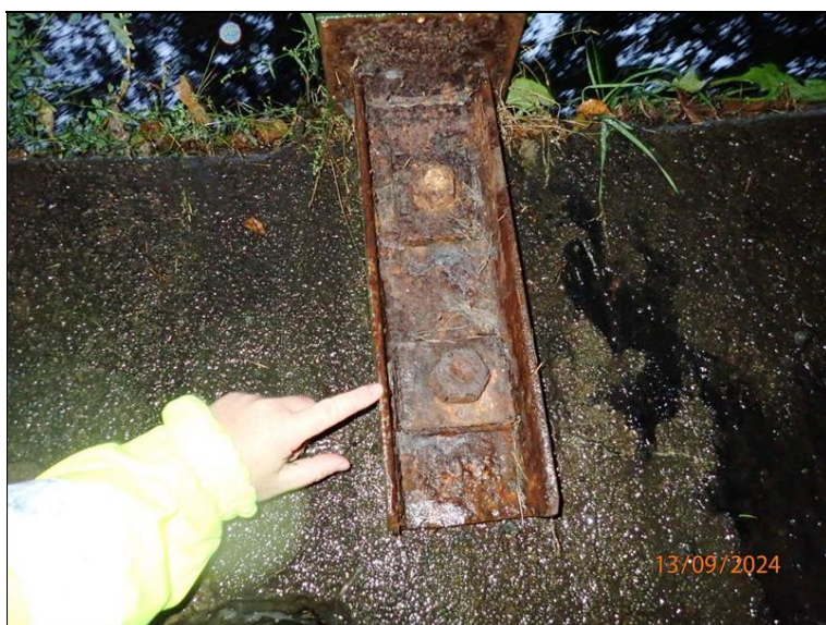
P bok mostu, detail korodujících šroubů a matic upevnění sloupku zábradlí.
